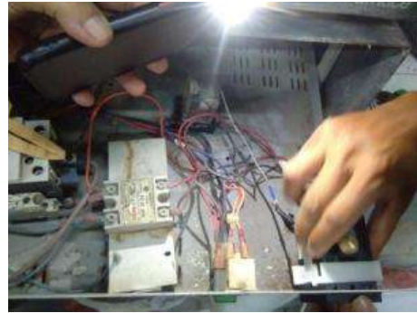
Gambar 6. Pemasangan sensor termokopel
